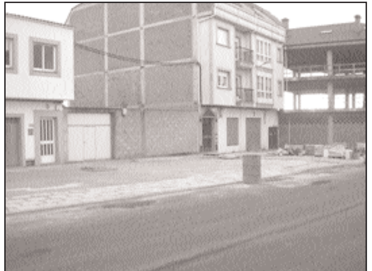
Estado actual da Praza Gaiteiros Garceiras, en obras
