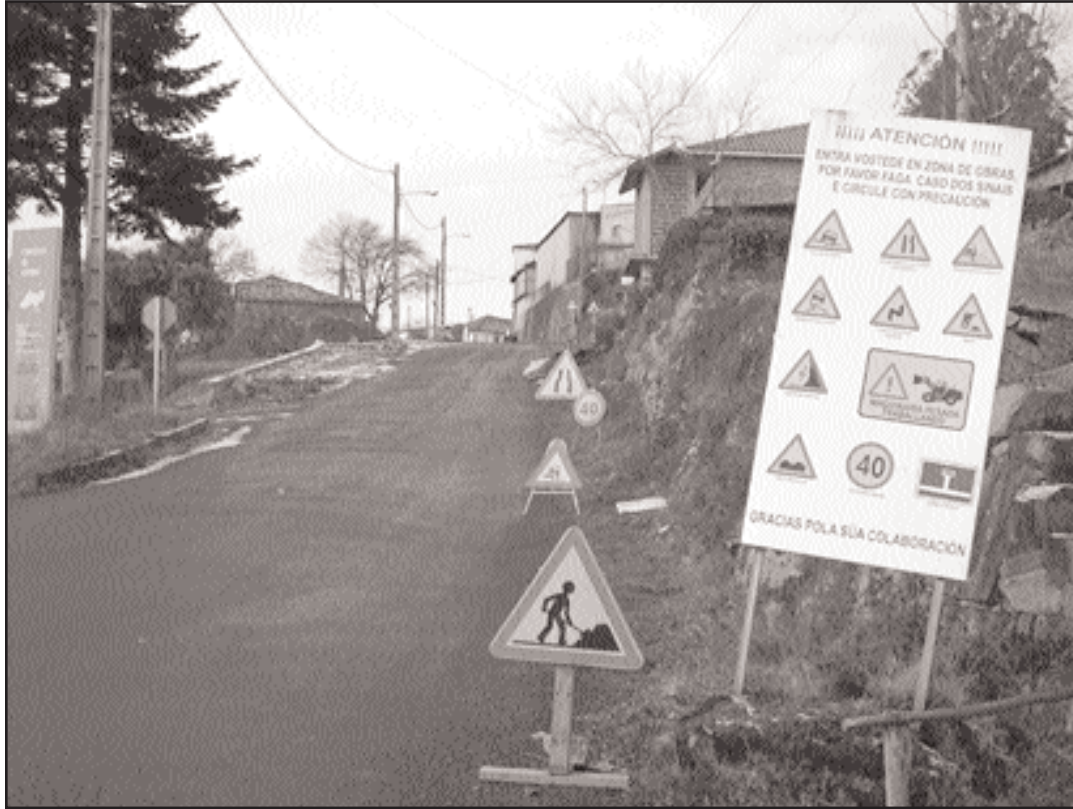
A Deputación está a traballar nas obras de ampliación da estrada en Chorén
