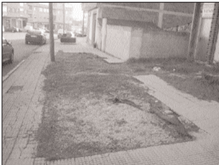
Estado actual dun tramo das beirarrúas da Codeseira
