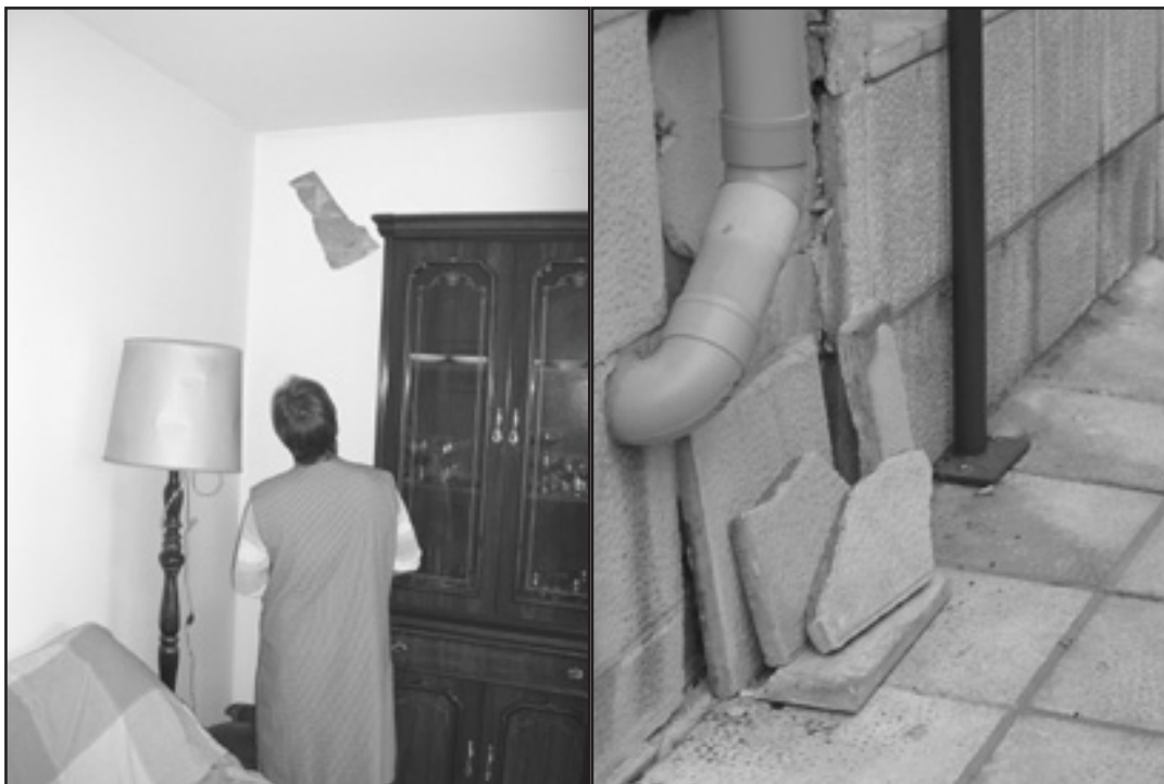
Existen problemas desde que foron entregadas aos veciños, en 1998
