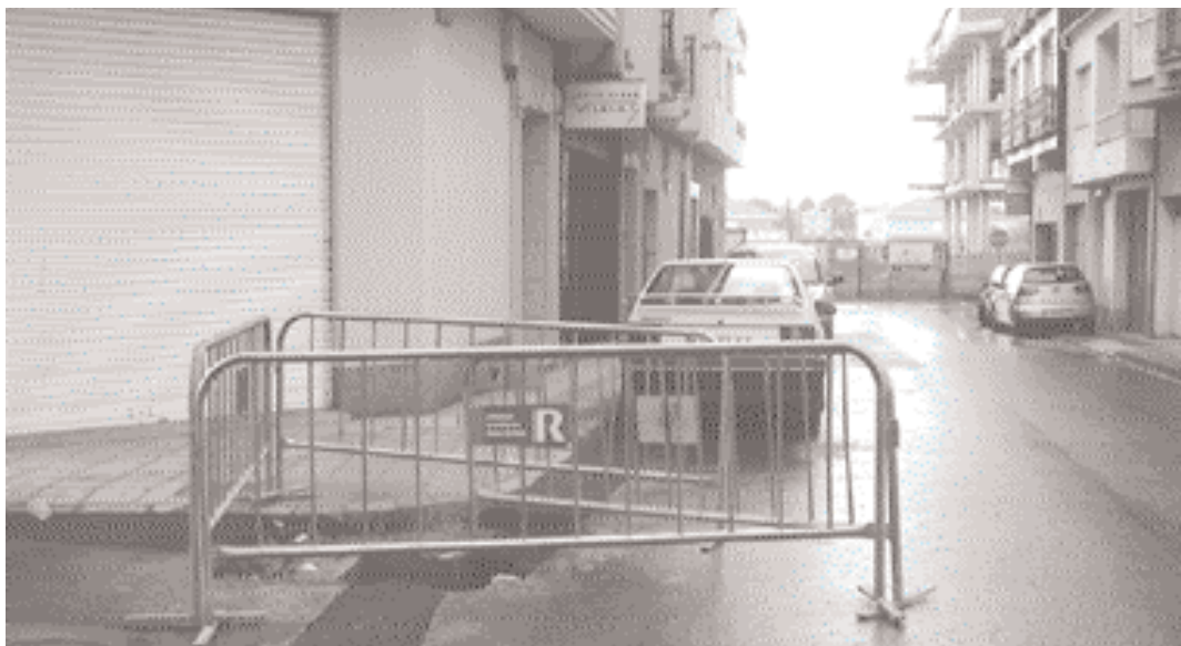
A Avenida de América é unha das rúas onde se están a levar a cabo as obras
