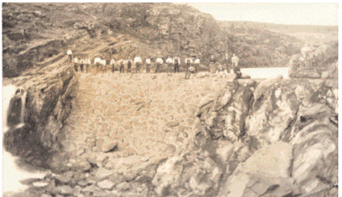
Imaxe que amosa o remate da construción da presa do Salto de Portodís, no Rechinol. Ano 1922
