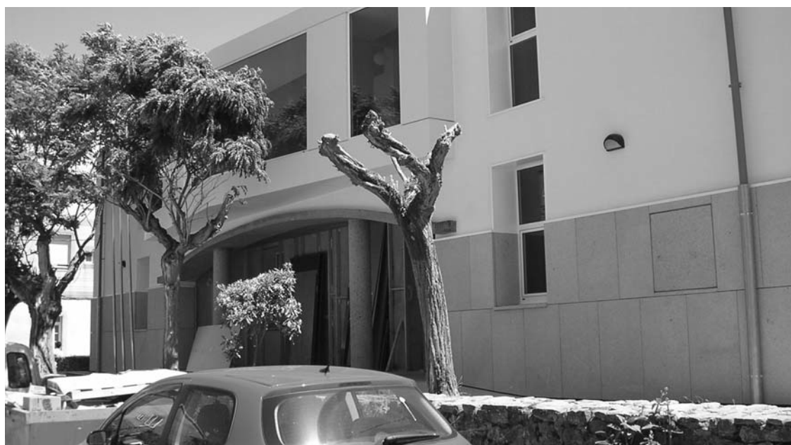
A reforma do exterior do edificio está practicamente rematada
