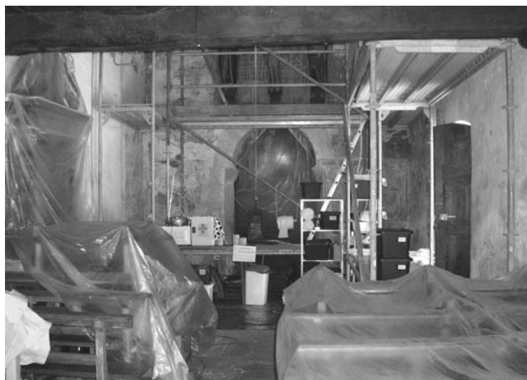
Andamios colocados no interior da Capela
