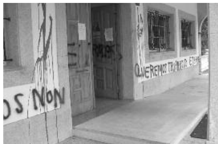
Pintadas na fachada da Casa do Concello de Santiso
