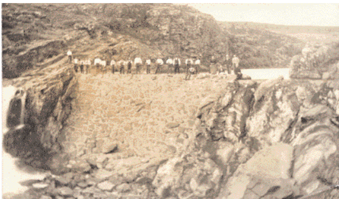
Imaxe que amosa o remate da construción da presa do Salto de Portodís, no Rechinol.
