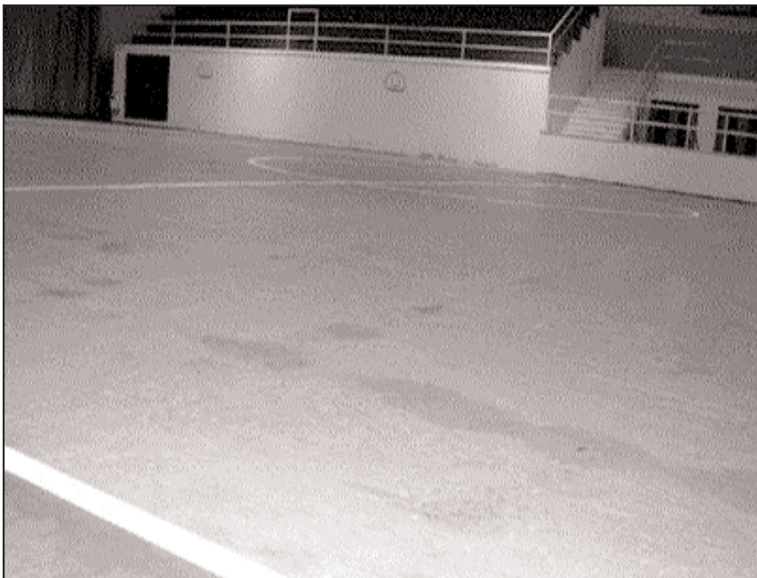
As manchas de aceite da pista de xeo deixaron inservible a instalación
