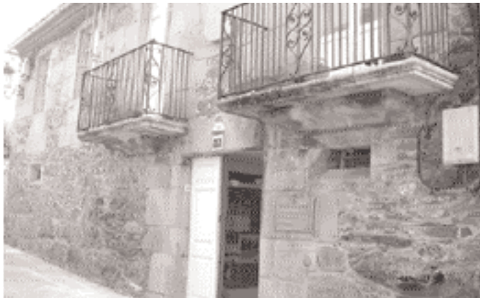
O CIM atopáse no interior da casa do Centro Social
