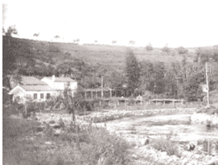
Primeira central hidroeléctrica de O Rechinol (1909)
