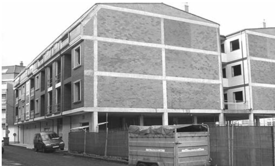
Edificios en construción no casco urbano de Melide
