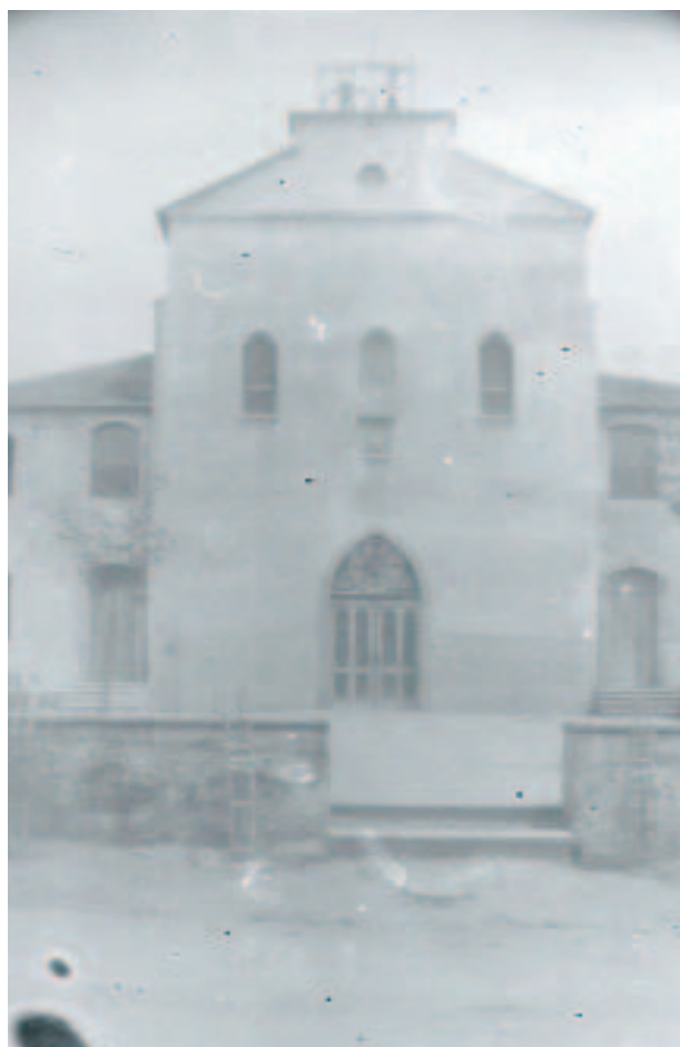
Convento dos Pais Pasionistas. Priorada, Melide. (Ano 1914). Pasionistas en Melide 1909-2009
