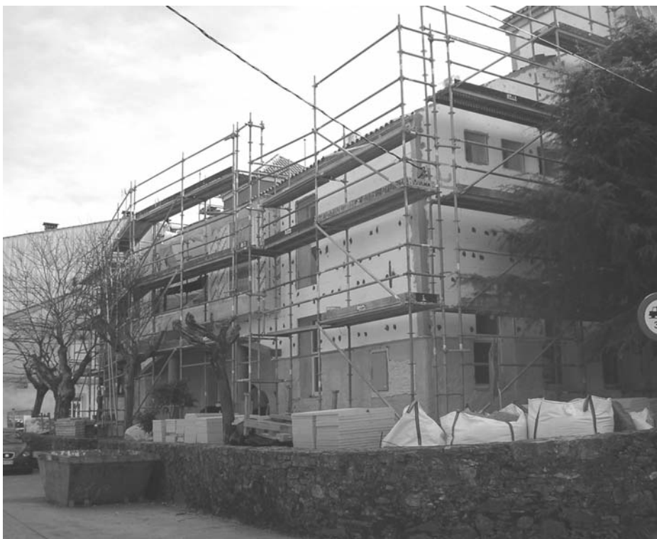
As obras do albergue municipal avanza en prazo, segundo o Xacobeo
