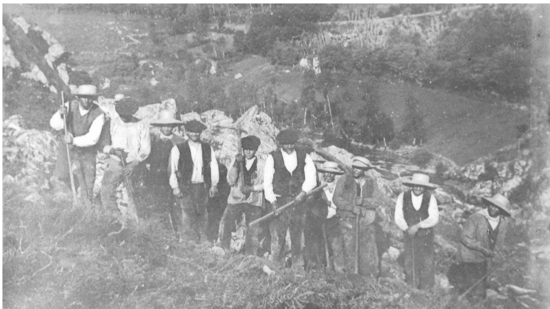
Rematando as obras da central de Portodís. (Anos 1920)
