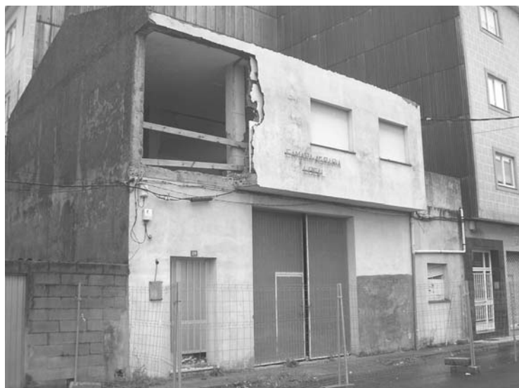
Estado actual da Cámara Agraria, na rúa Froito Novo
