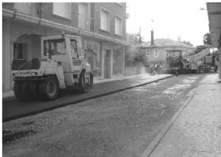
Obras na rúa Lino Sexto Sánchez
