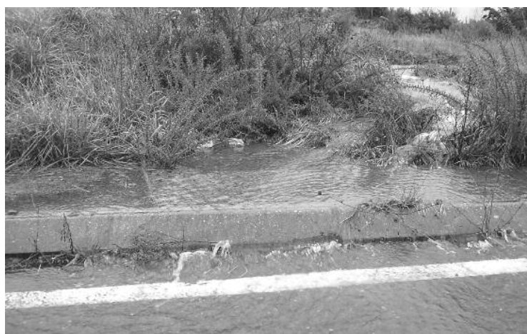
A auga sen canalizar anega algunhas rúas do polígono
