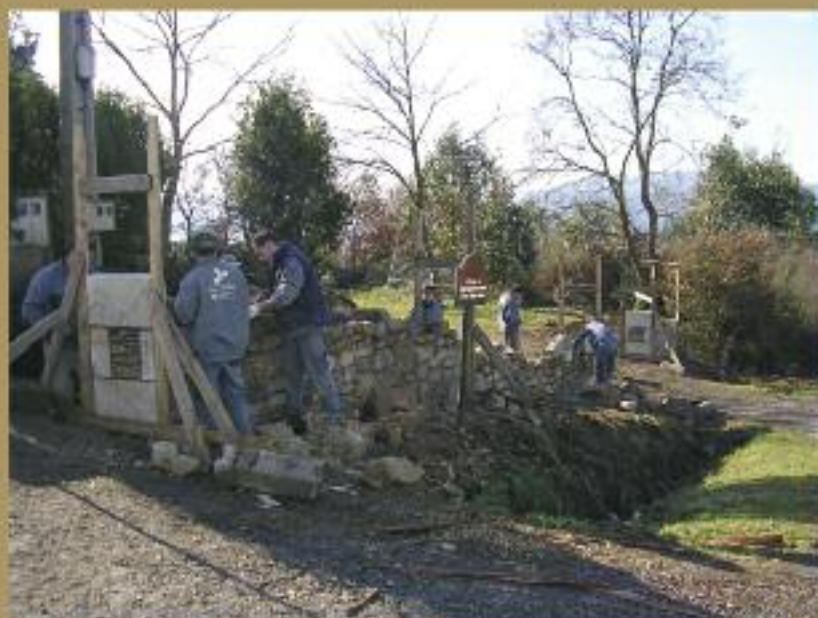
Obradoiro de cantería
