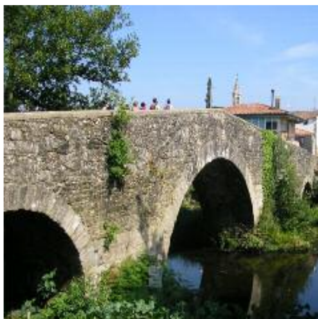
Ponte románica de Furelos
