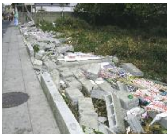
Varias persoas derrubaron un muro de bloques na rúa Galicia, en pleno centro de Melide
