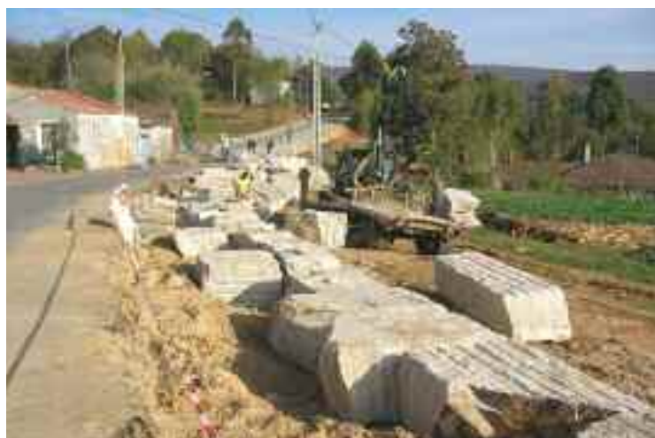
Construción do muro de contención na parroquia de Villamor
