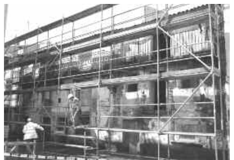
A colocación dos andamios comezou o 7 de maio
