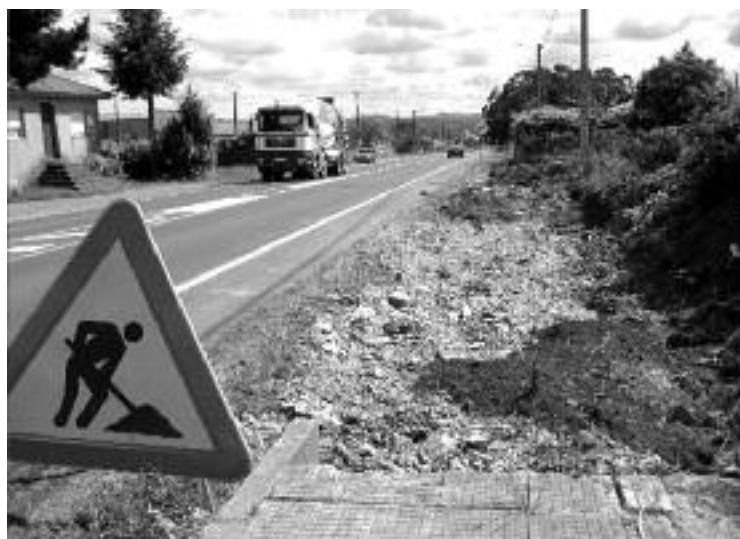
Movemento de terras na área afectada pola construción da senda
