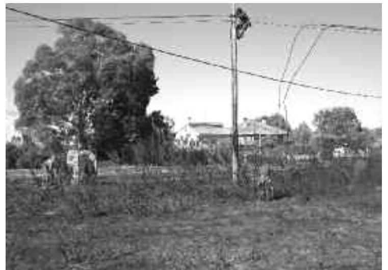
Operarios reparando a liña telefónica afectada polo incendio
