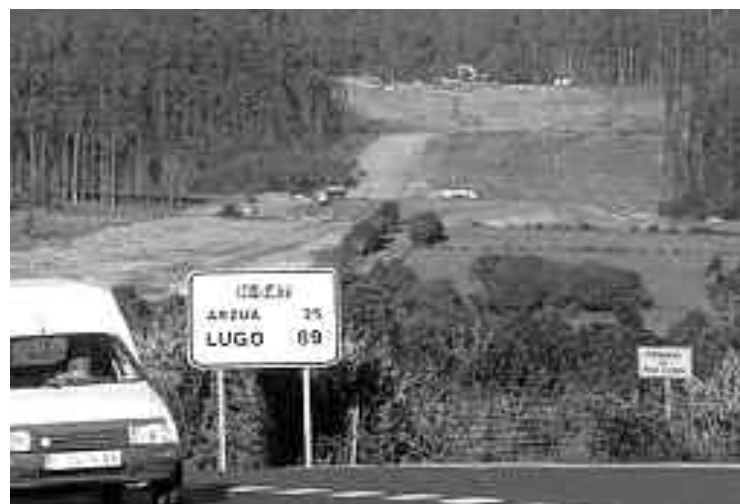
Estrada Santiago-Lugo coas obras da autovía ao fondo (ano 2010)
