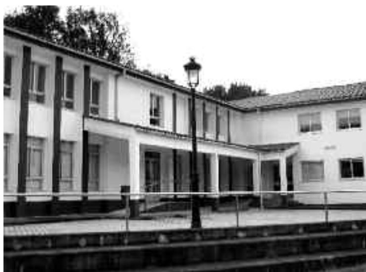
A Xunta instou a acometer reformas no edificio antes da apertura
