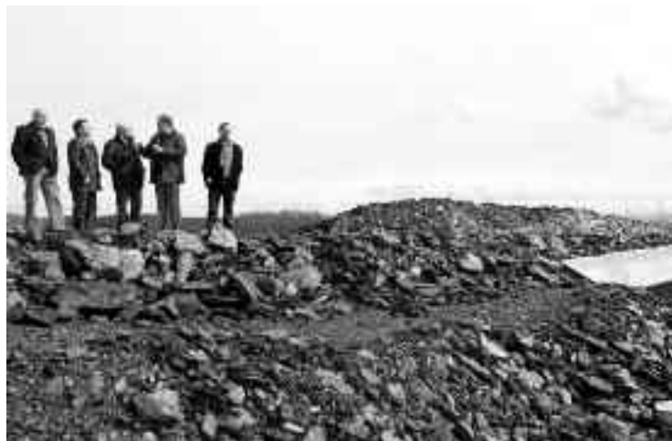
Socialistas de Melide, Guntín, Palas e Monterroso nas obras da A-54
