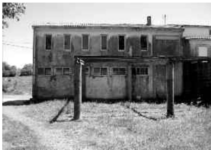
O parque construírse detrás da escola de Brañas
