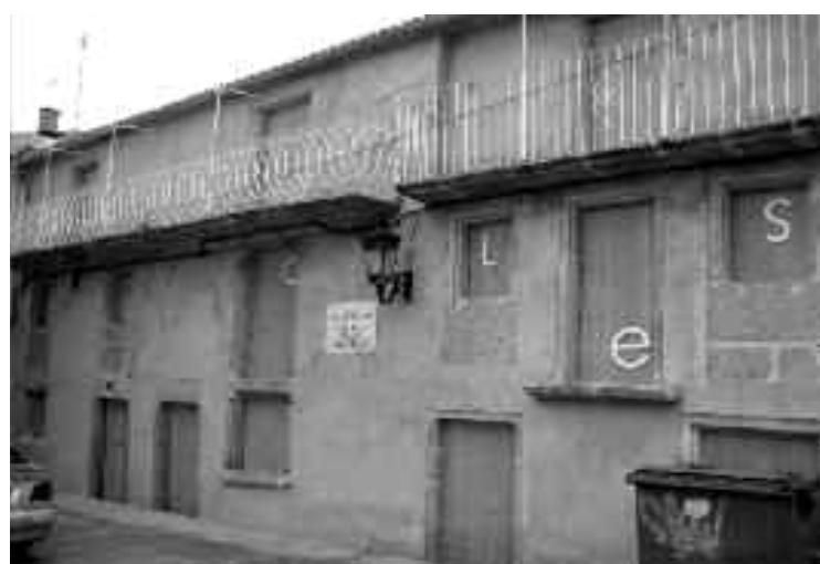
As vivendas foron rehabilitadas parcialmente polo Xacobeo no 2012
