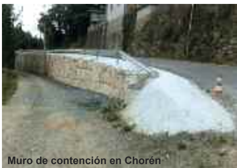
Vía de formigón en Eirexe (Serantes)
