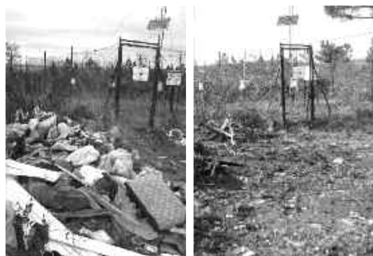
O vertedoiro antes e despois da retirada de residuos
