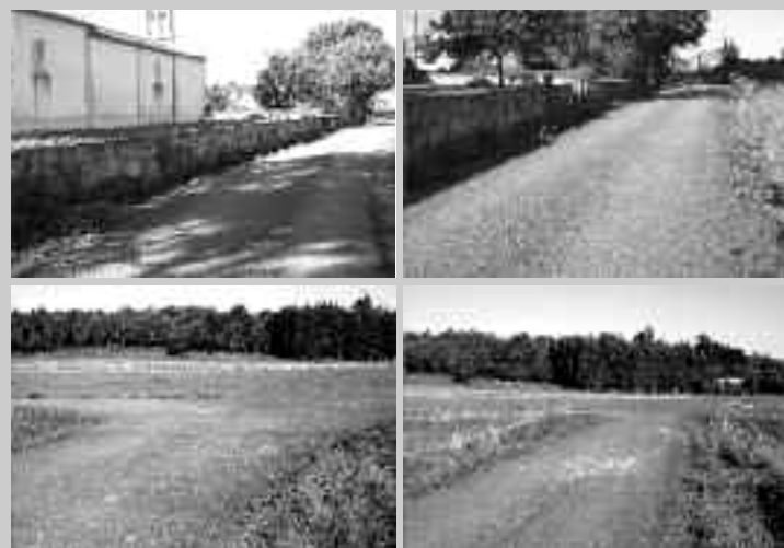
Arriba, asfaltados en Vimianzo. Abaixo, camiños en Barazón
