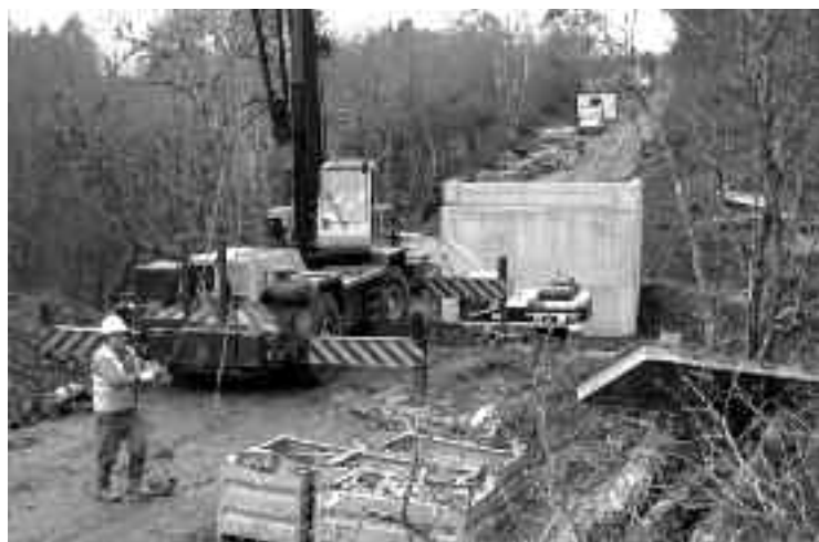
Os operarios traballan na construción do segundo piar da ponte
