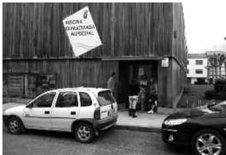
As instalacións da piscina climatizada levan dous anos pechadas
