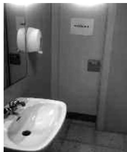
Os baños están habitualmente avariados segundo denuncia o PSOE
