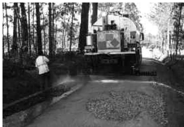
Pistas asfaltadas recentemente na parroquia de San Román
