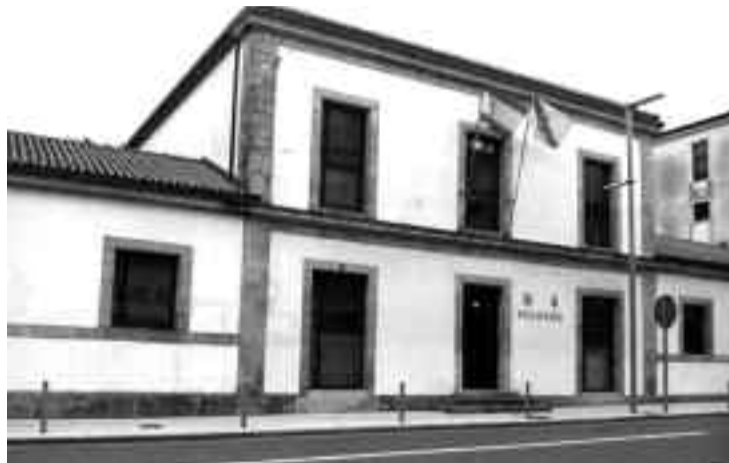
Vista xeral dos xulgados de Arzúa, na estrada de Lugo
