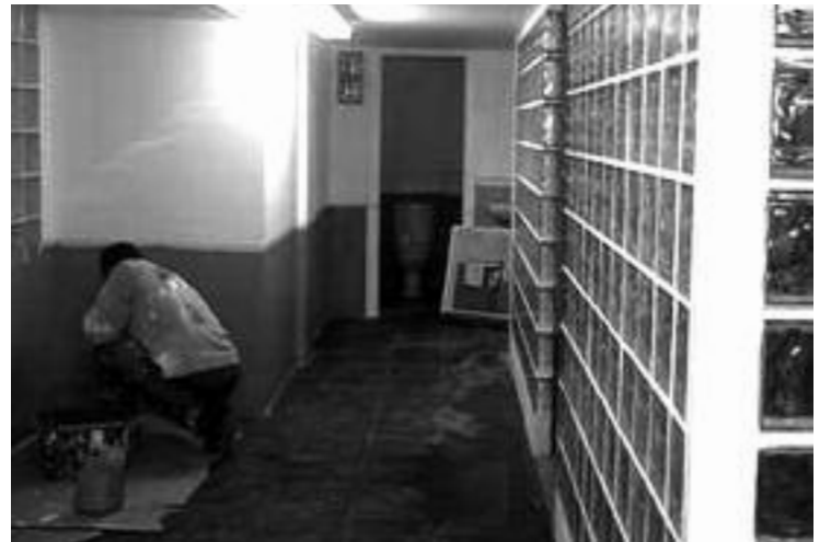
As reparacións feitas dende 2011 en adiante foron insuficientes
