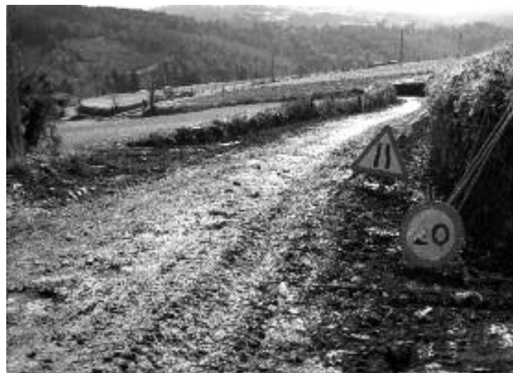
Limpeza de cunetas previa ao asfaltado no lugar de Albín
