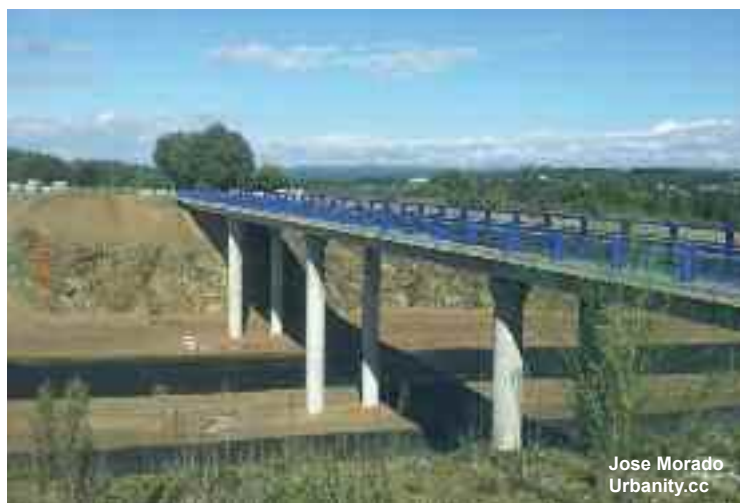
As obras xa están moi avanzadas nos tramos entre Palas e Lugo
