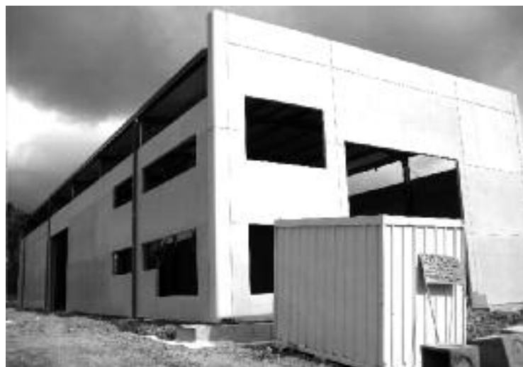
Nova nave case rematada que acollerá un taller mecánico
