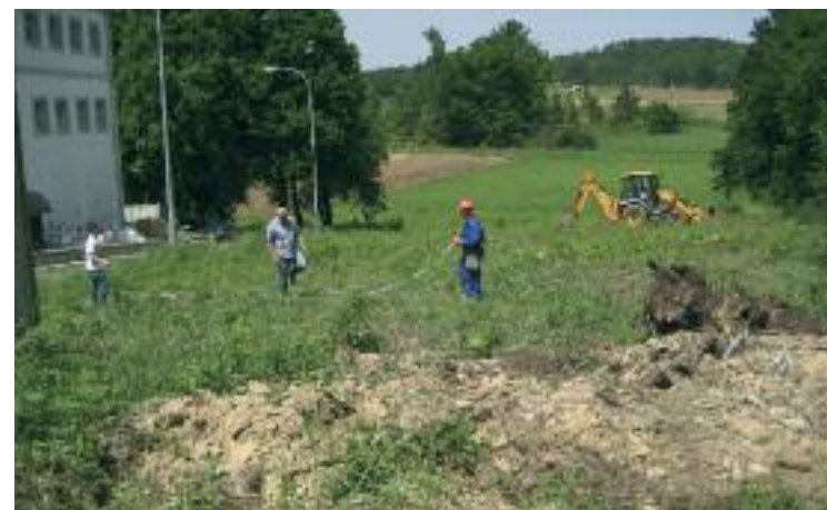
Operarios levantando a acta de replanteo do tanatorio
