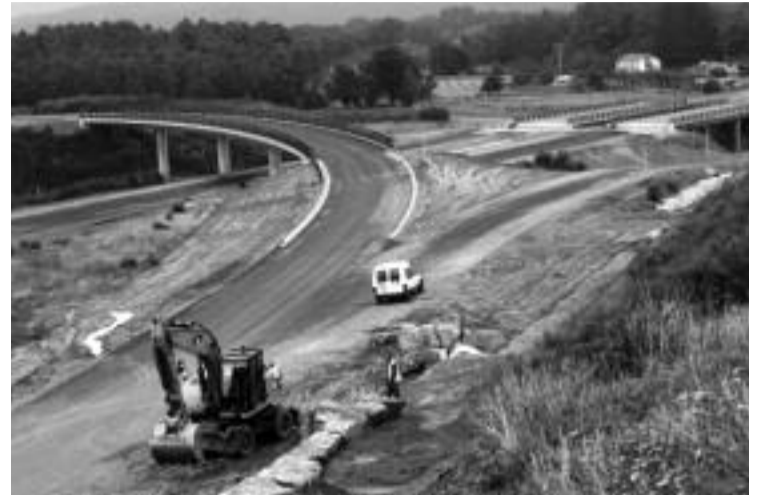
Obras nun dos tramos da A-54 (Jesús Ponte)
