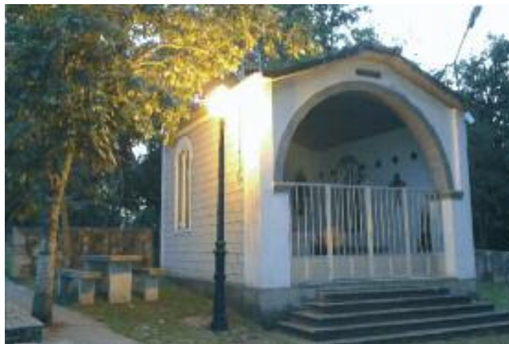
Iluminación pública no campo da festa da Ponte
