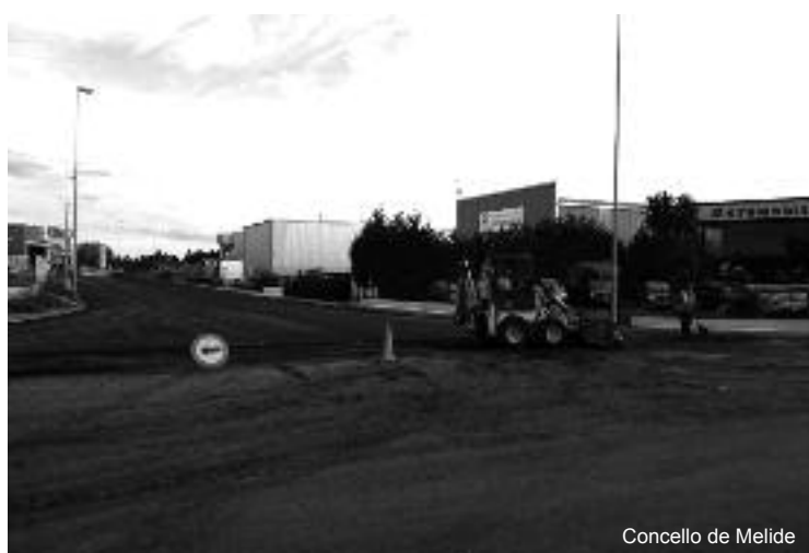
Obras de asfaltado no polígono, este mes de outubro
