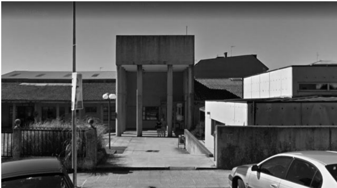
As instalacións do antigo Centro de Saúde de Melide. /Foto: Cerne
