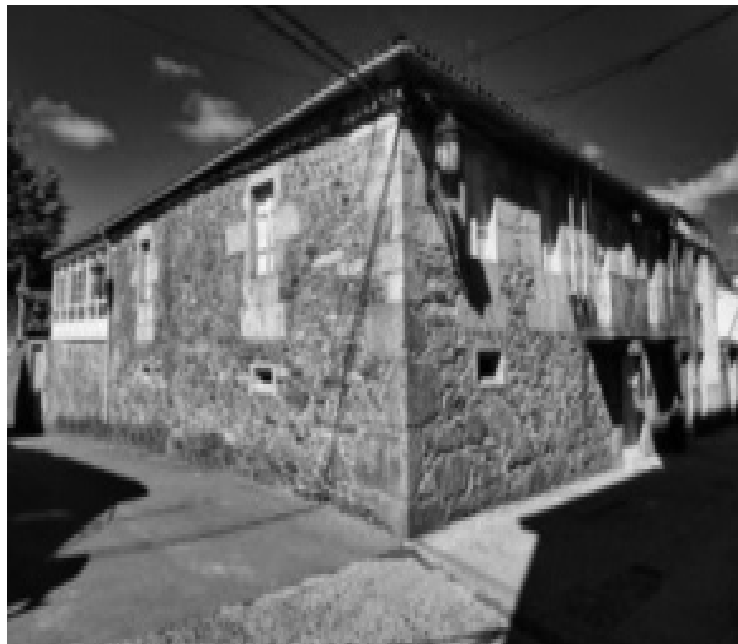
Edificio do Centro Social de Melide. / Foto: Concello de Melide
