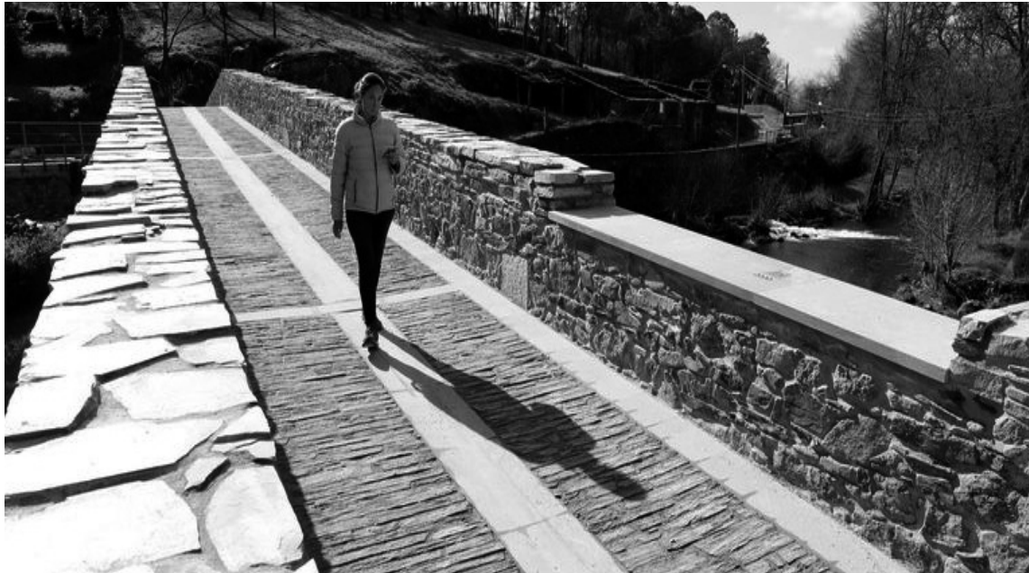
A Ponte Medieval de Furelos na actualidade, logo das obras de rehabilitación. / Foto: Sandra Alonso
