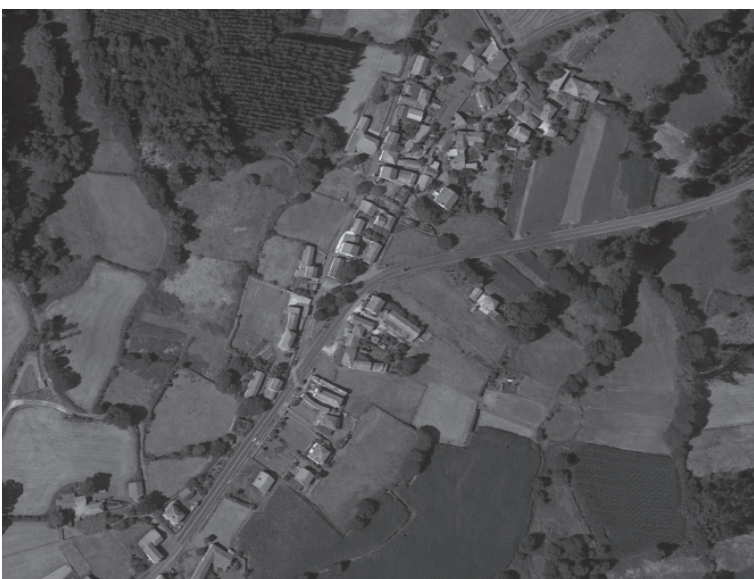
A estrada DP-4603 na que se realizarán melloras. / Foto: Deputación da Coruña
