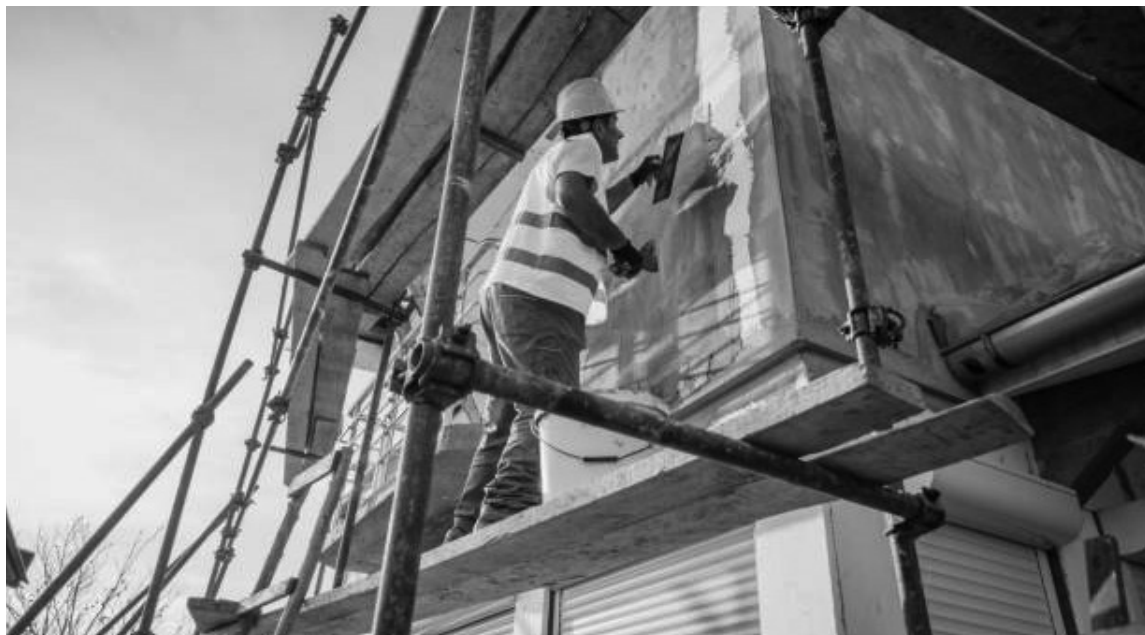
Un obreiro traballando nunha obra de mellora de eficiencia enerxética como o destas axudas. / Foto de arquivo
