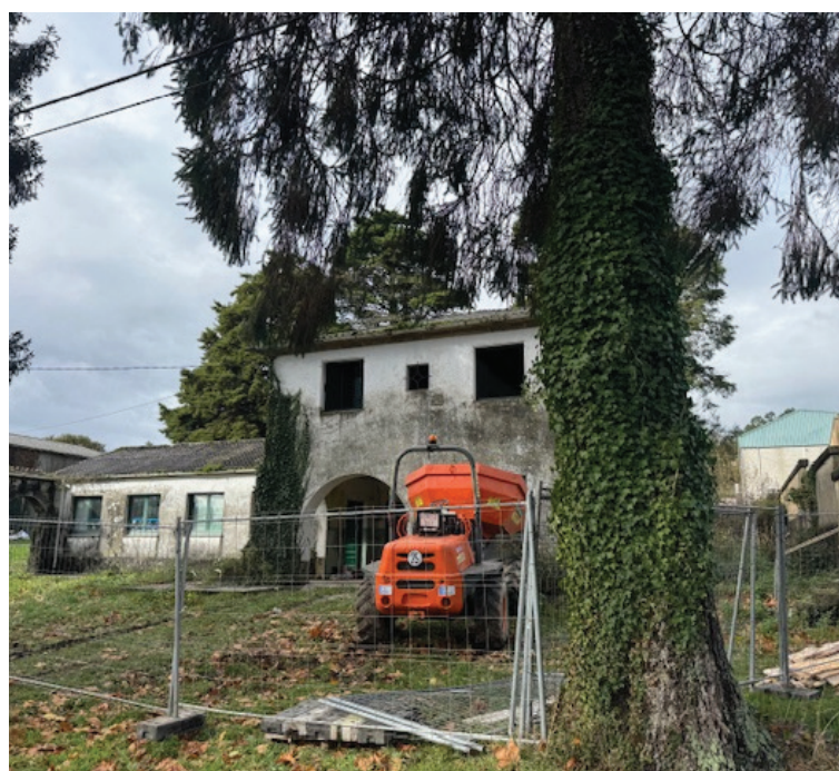
As obras de rehabilitación para o Centro de Día. / Foto: Concello de Sobrado
