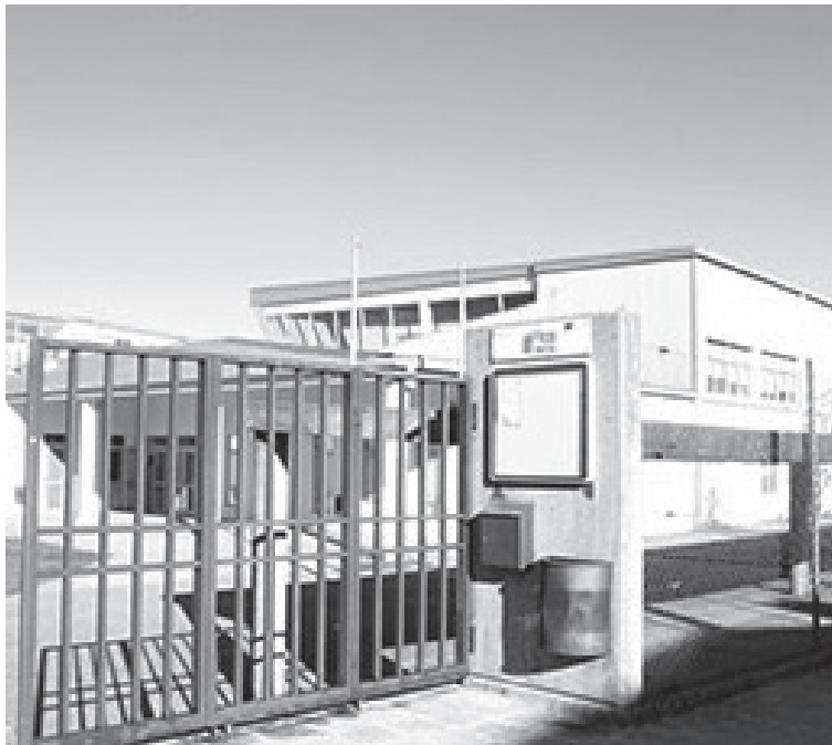
As instalacións do IES de Melide dende a rúa. / Foto de arquivo
