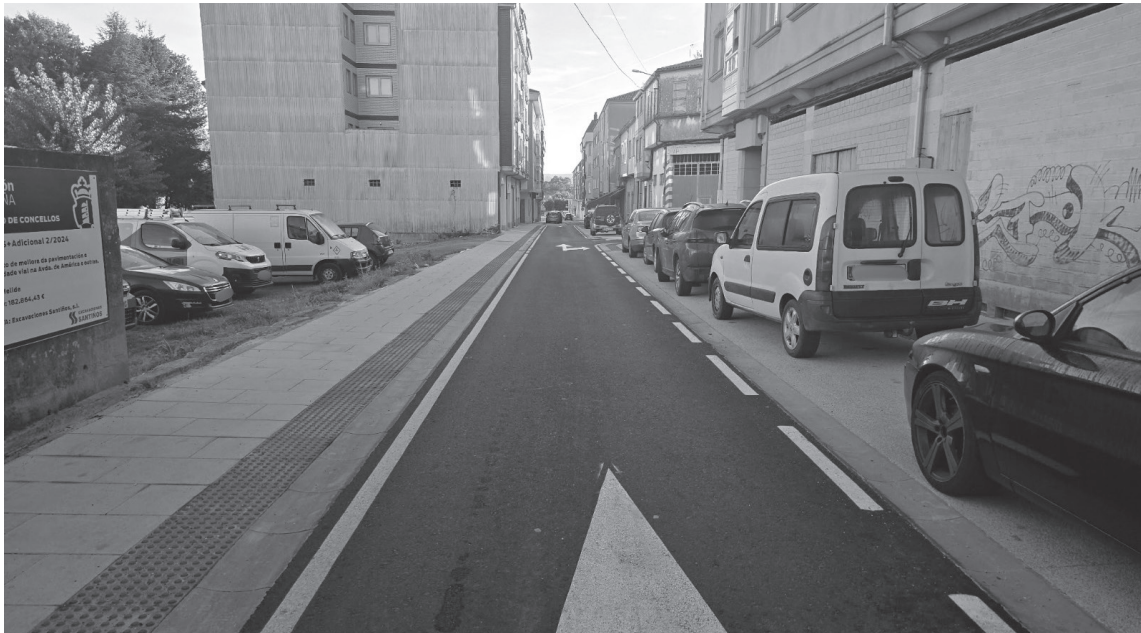
Unha das rúas nas que se fixeron obras de mellora da pavimentación e seguridade viaria. / Foto: Concello de Melide
